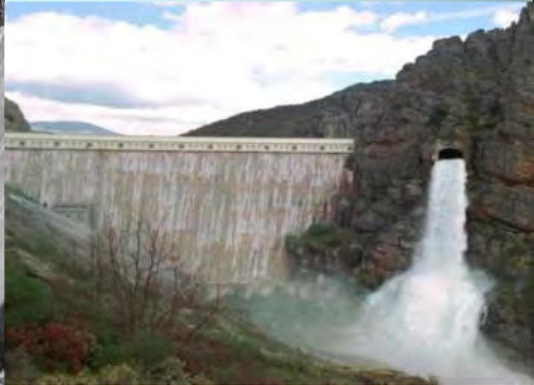
**ALIVIADERO DE LA MARGEN DERECHA ANTES DE LA AMPLIACIÓN REALIZADA A PARTIR DE 1938 (40 a 60 m<sup>3</sup>/s) Y DE 1945 (60 a 200 m<sup>3</sup>/s) Y EL NUEVO ALIVIADERO DE LA MARGEN IZQUIERDA. 200 m<sup>3</sup>/s (1966)**
