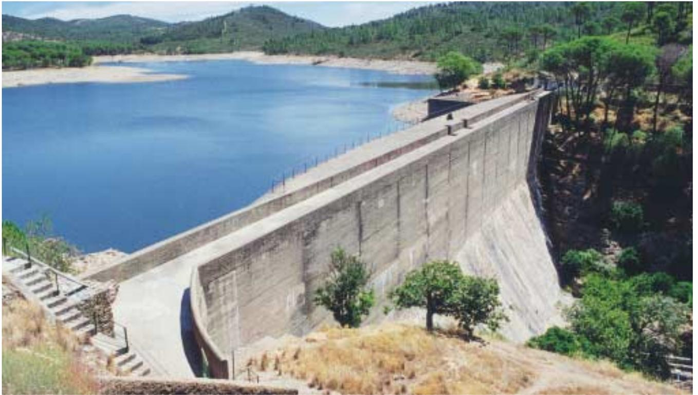
Fig. 5. Presa de Campofrío. Recrecido de hormigón sobre la presa inicial de mampostería y sillería. (Fuente: vid. referencia 6).
