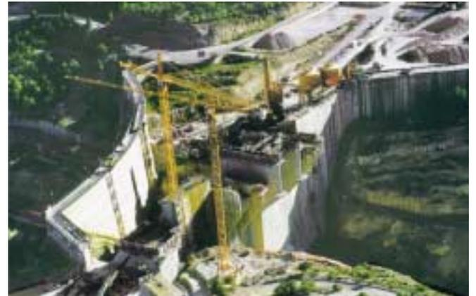
Fig. 6. Construcción de la presa de Puentes IV inmediatamente aguas arriba de la de Puentes III. (Fuente: Ministerio de Medio Ambiente).
