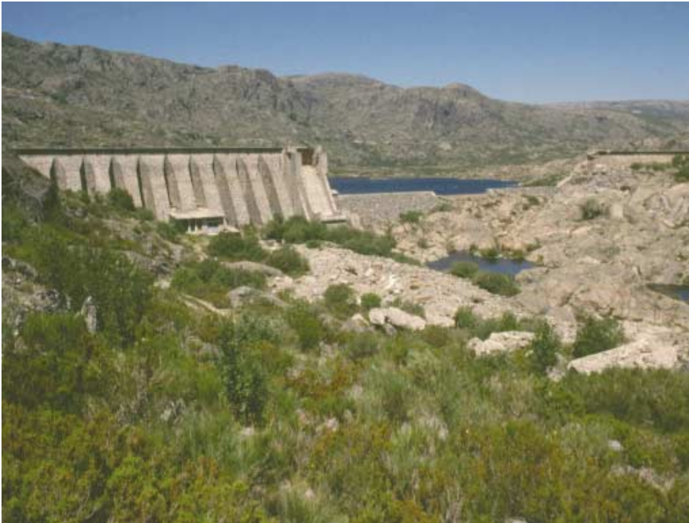
Fig. 1. Presa de Vega de Tera en su estado actual, tras la rotura de 1959 (Fuente: Miguel Ayuso).
