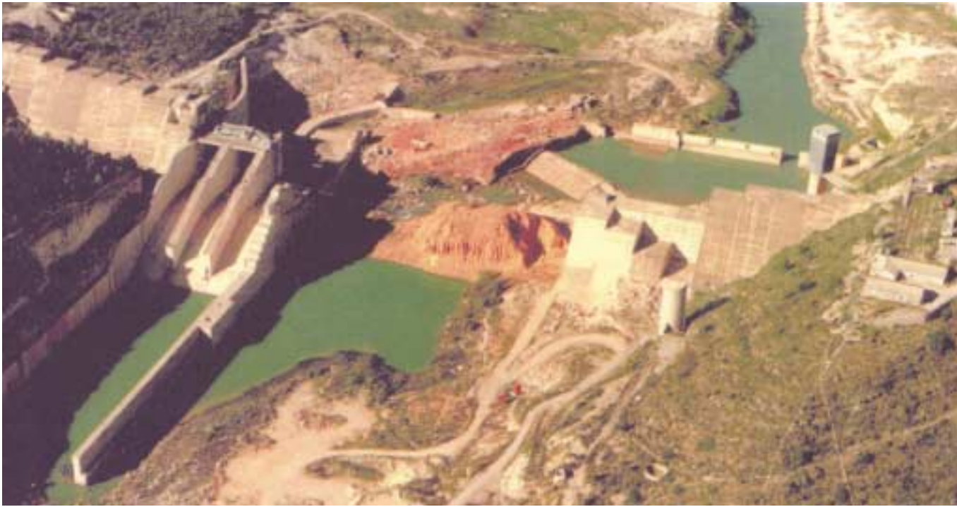
Fig. 2. Aspecto de la presa de Tous en enero de 1990 (Fuente: Confederación Hidrográfica del Júcar).
