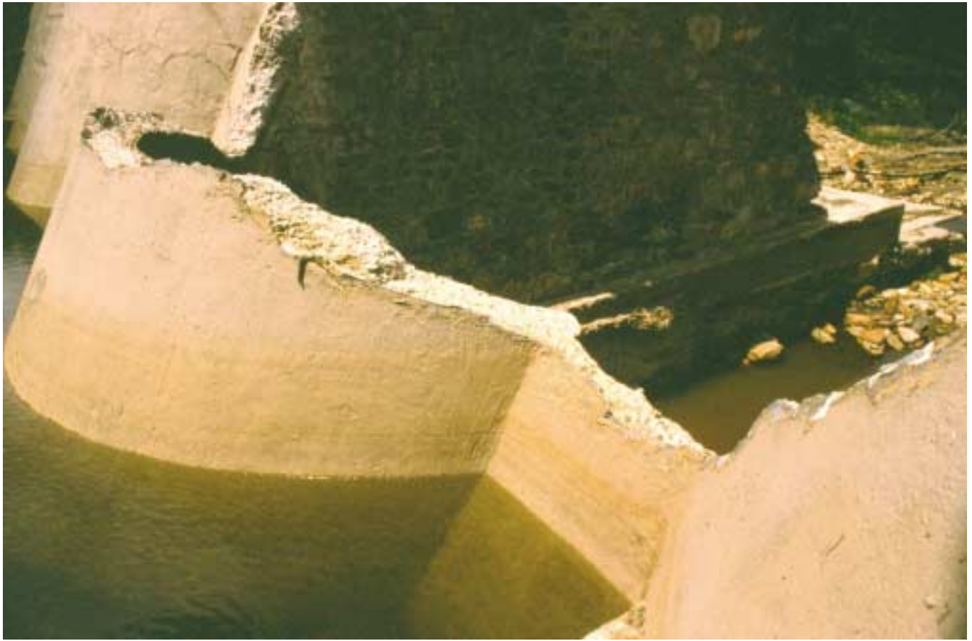
Fig. 3. Detalle de la rotura de la presa de Orjales (Fuente: Miguel Ayuso).
