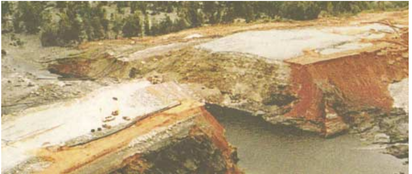
Fig. 4. Detalle de la rotura en 1998 de la presa de la balsa de residuos mineros de Aznalcóllar (Fuente: "Diario 16").
