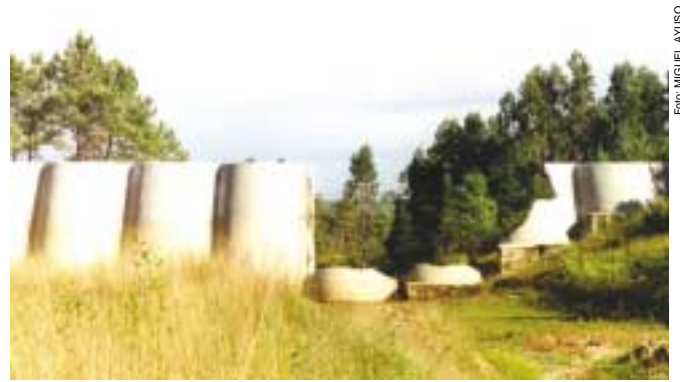
Fig. 2. El riesgo acompaña a la presa durante toda su vida. Presa de Orjales, rota tras 36 años de servicio.
