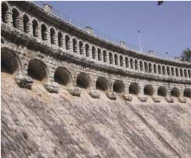
Fig. 2. Presa del Conde de Guadalhorce en Málaga.
