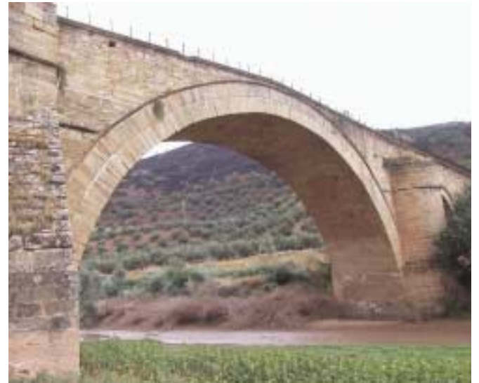
Fig. 3. Puente de Ariza en el río Guadalimar.
