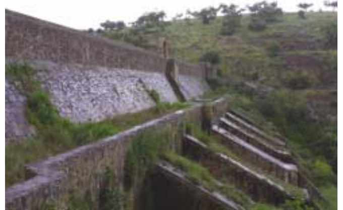
Fig. 7. Presa de la Albuera de Feria.
