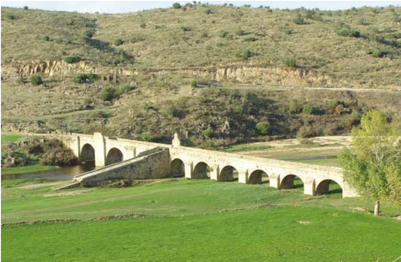
Fig. 1. Puente de Jaraicejo en el río Almonte.
