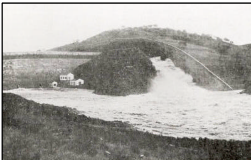
Figura 4. El aliviadero lateral inicial durante una avenida.
