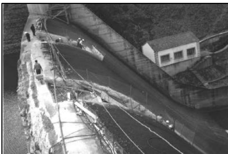
Figura 7. Obras de reforma y terminación en el aliviadero.
