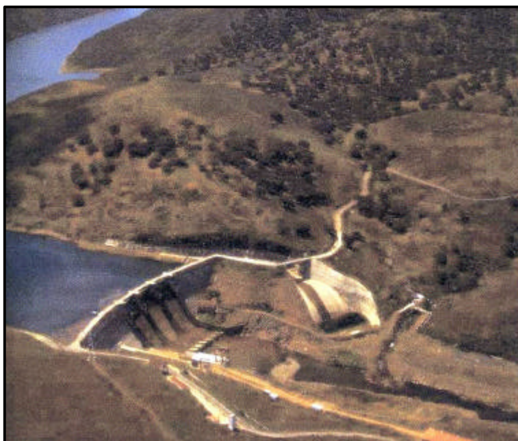
Figura 1. Vista aérea de la presa del Águeda.
