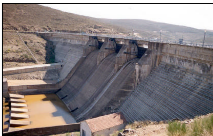
Figura 8. Estado actual del aliviadero frontal.
