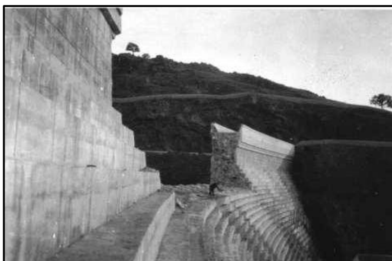
Figura 5. El “portillo” abierto en coronación.
