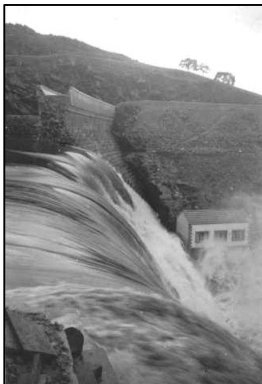
Figura 6. Vertido de una avenida sobre el “portillo”.
