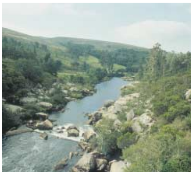
Fig. 5. En el norte, la climatología resuelve de forma rápida las alteraciones producidas aguas abajo de la presa.
