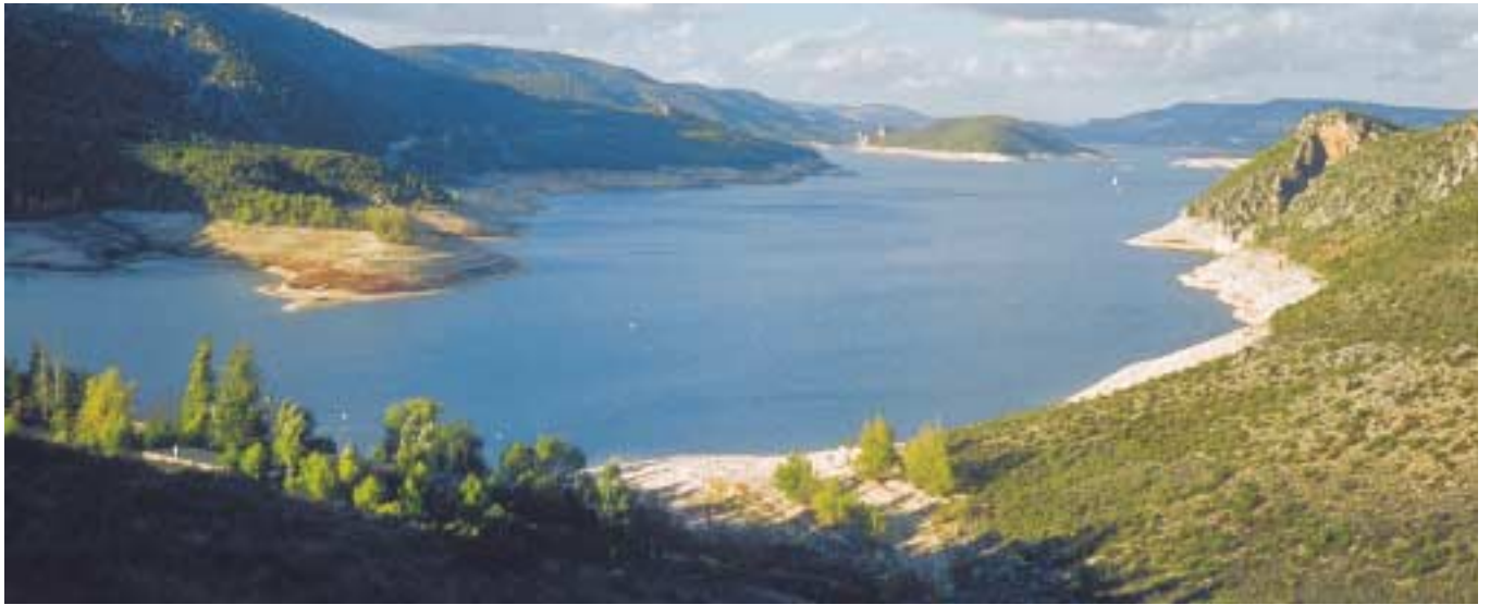
Fig. 3. La variación del nivel del agua impide que se instale una cobertura vegetal en la orilla del embalse.
