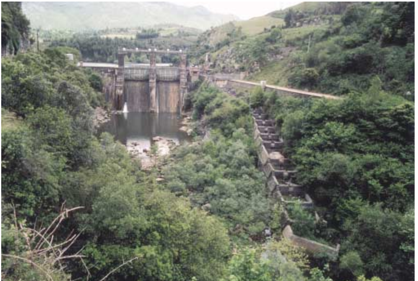
Fig. 11. Las medidas correctoras, como esta escala de peces, solucionan los problemas de comunicación de las especies piscícolas.
