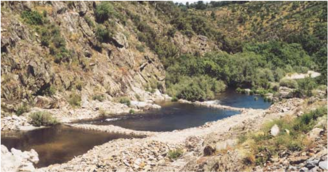
Fig. 5. El sistema de decantación de aguas tiene su final en dos balsas situadas en el propio cauce, por debajo de la zona de obras.
