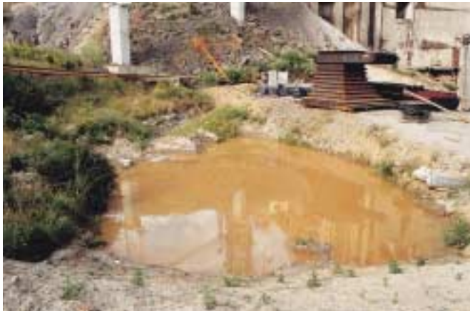
Fig. 2. Se ha instalado un sistema de balsas de decantación para recoger las aguas utilizadas en los diferentes procesos constructivos. Balsa situada junto a la planta de hormigonado.
