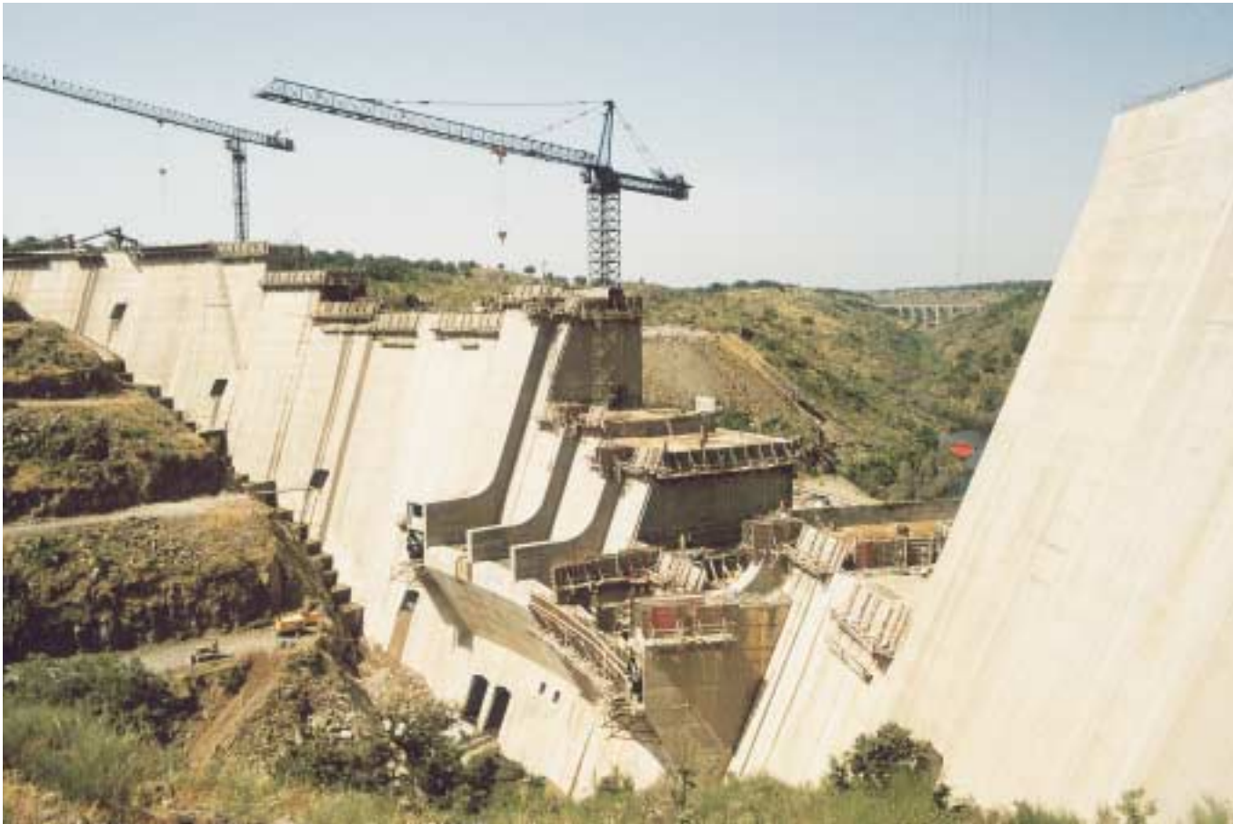
Fig. 1. Estado de las obras de construcción de la presa de Trueña en junio de 2002.
