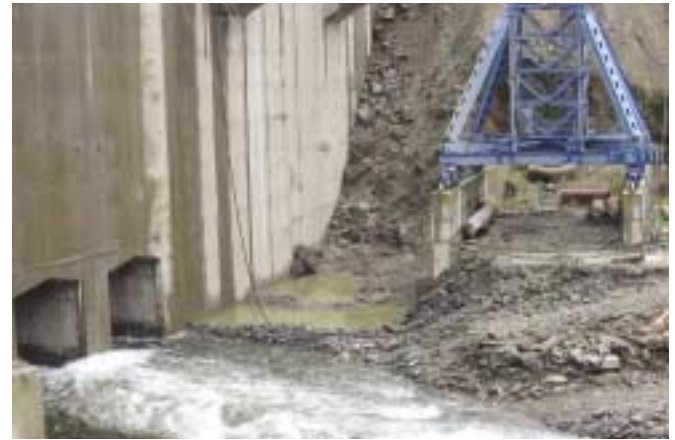
Fig. 3. Balsas situadas junto al muro de aguas arriba, en la margen derecha, para recoger las aguas procedentes del lavado de los bloques.
