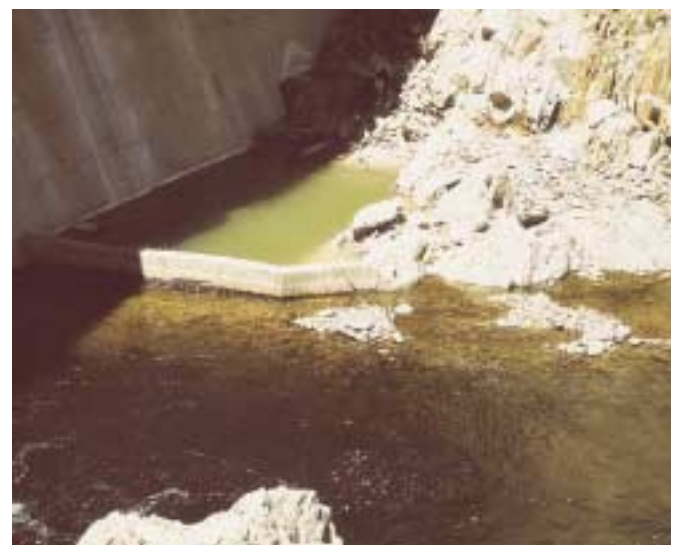
Fig. 4. Balsa de decantación situada a pie de presa, aguas abajo.
